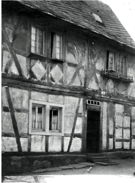
Ältere Aufnahme des Gebäudes mit der Hausinschrift oberhalb der Haustür
